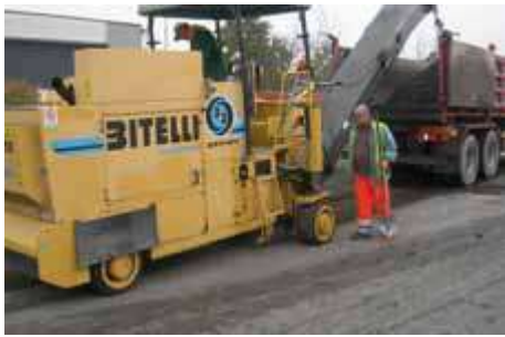
Frézování vozovky
