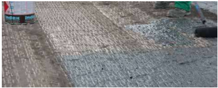
Nanášení penetračního nátěru ECOVER v množství 200-300 g/m 2
