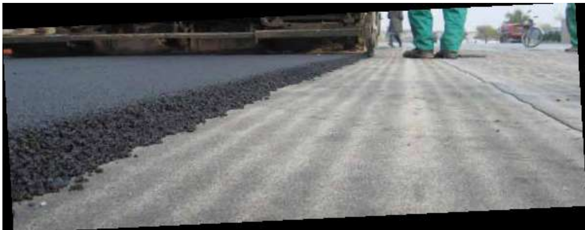
Pokládka nové asfaltové směsi na samolepící pás AUTOTENE PK
